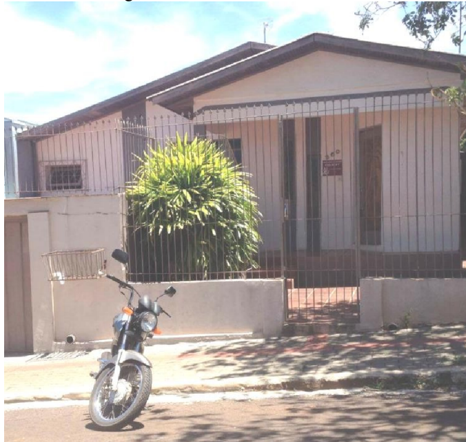
Figura 01 – Fachada do laboratório
